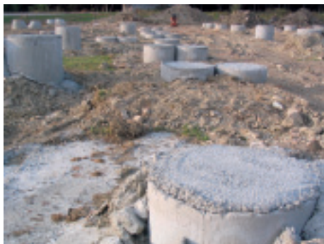
Rund 100 Betonsäulen tragen die neue Halle
