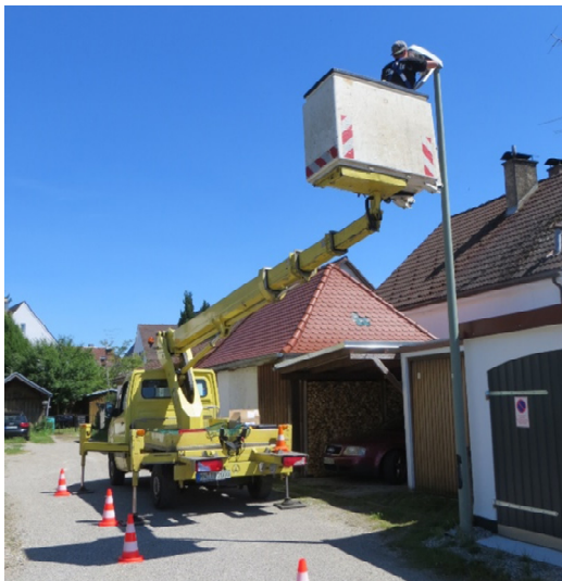
Bild 1: Tausch des Leuchtmittels
